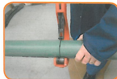
Kapning av sekundärrör UPP med röravskärare
