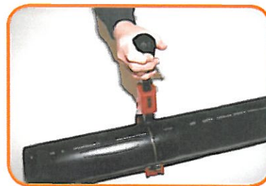
Kapning av primärrör UPP med röravskärare
